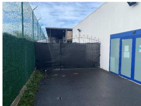
Foto 8: Zuidzijde tussen winkel en perceelsgrens
