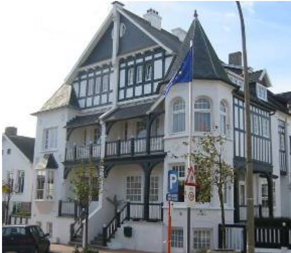
De villa van vier woningen gelegen in de Duinbergenlaan 73, 75 en Duinendreef 40, 42
