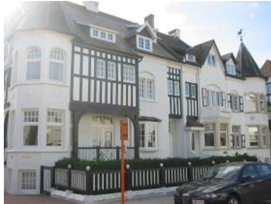
De villa van vier woningen gelegen in de Duinbergenlaan 73, 75 en Duinendreef 40, 42
