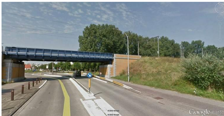
Spoorwegbrug boven de Heistlaan. Foto genomen ten zuiden van de spoorwegberm
