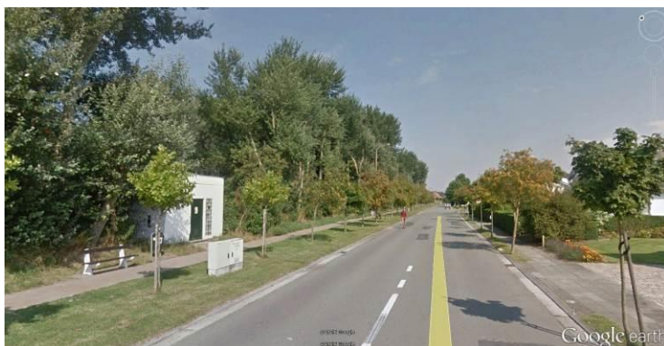
Zicht op Scheurleg met rechts de bestaande voortuintjes en links de groenstrook met schermfunctie (witte abeel met onderbegroeiing).
